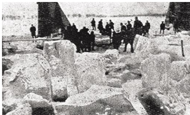
Ulanów nad Sanem. Uwalnianie mostu od lodu
